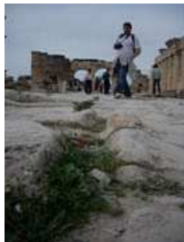
Foto 94: Canalización de agua
