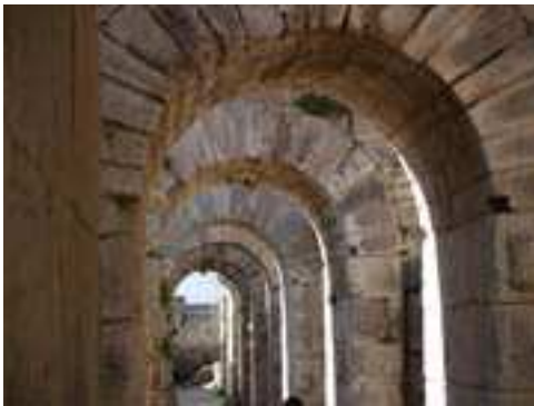
Foto 147: Arquerías bajo Templo de Trajano
