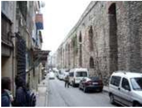
Foto 235: Comienzo del Acueducto de Valens
